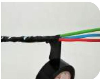
Passa fita isolante cobrindo as emendas dos condutores para evitar que agarrem no interior do eletrodo
