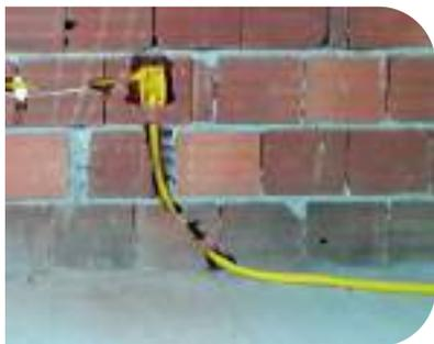
Eletroduto embutido na parede
