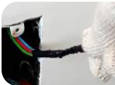
Quando a sonda sair no ponto desejado, puxe os condutores o suficiente para terem o comprimento apropriado
