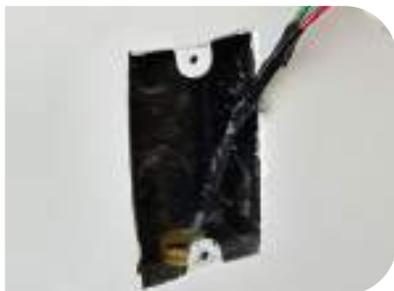
“Empurre” a sonda pelo eletroduto e cuide para que a fita isolante não “agarre” na entrada. Use luvas para evitar machucar as mãos
