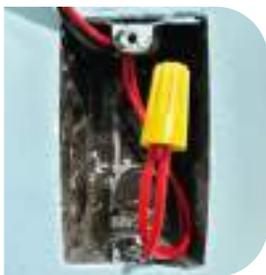
Emenda com conector, que não requer fita isolante
