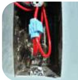
Uso do conector em uma caixa de passagem da instalação
