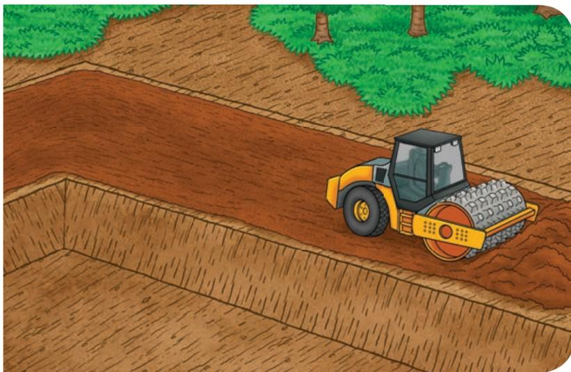
Em geral, o solo cortado e transportado para o aterro contém umidade adequada para uma boa compactação. Porém, se estiver demasiadamente seco, não garante uma compactação eficaz, sendo necessário aguardar a chuva ou regá-lo com caminhões-pipa.
