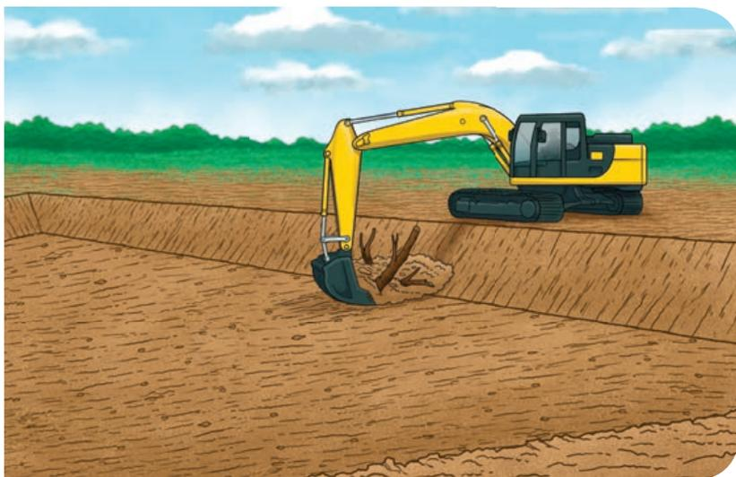
Nos casos de solos muito arenosos, com excesso de infiltração de água, pode ser construído um núcleo no talude usando solo com alto teor de argila. Esse núcleo deve ser construído cavando-se abaixo do nível do talude.
