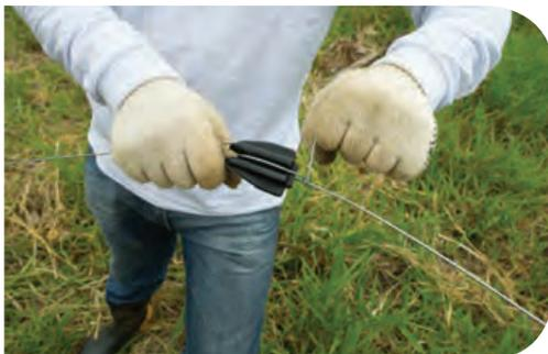
**4.2. Conecte a mola dissipadora no fio energizado, abrindo-a até que fique com 50 cm de comprimento, deixando o isolador centralizado**
