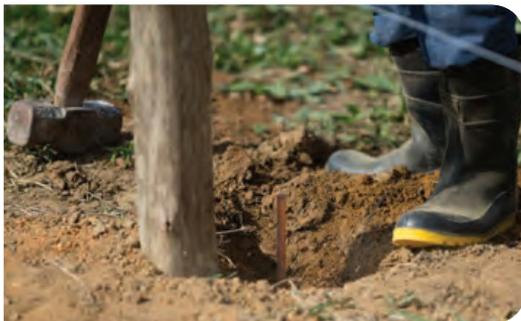
3.3. Corte o cabo de cobre na altura da haste até o desviador de raios
