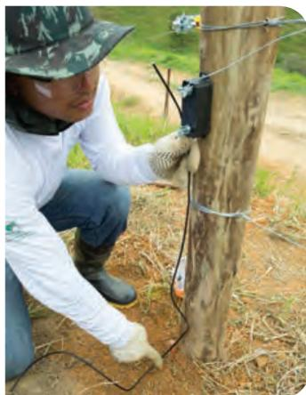
3.4. Ajuste o cabo de cobre na haste, apertando-o com o conector
