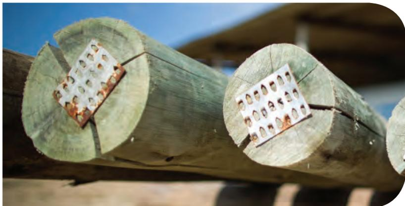
Os mourões da cerca elétrica têm a função de suportar e tracionar os fios. Possuem diâmetro maior que a estaca, pois sofrem maior pressão.
