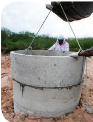
Rejunte os anéis expostos com cimento visando ter uma maior resistência durante as enxurradas no riacho/rio.
