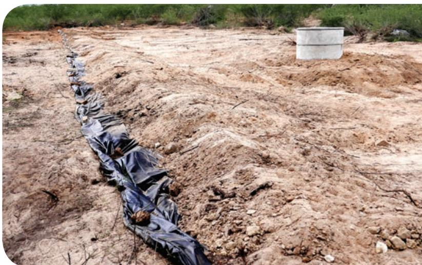
A instalação da barragem possibilita uma área de produção agrícola, em que a umidade do solo se prolonga por longo tempo, chegando até quase o final do período seco, tornando possível o cultivo de plantas com o sistema radicular mais profundo.
