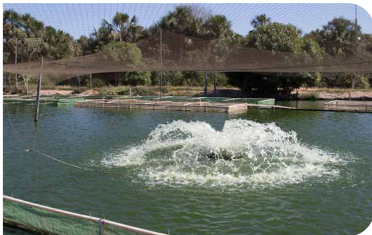
Aerador tipo chafariz em funcionamento
